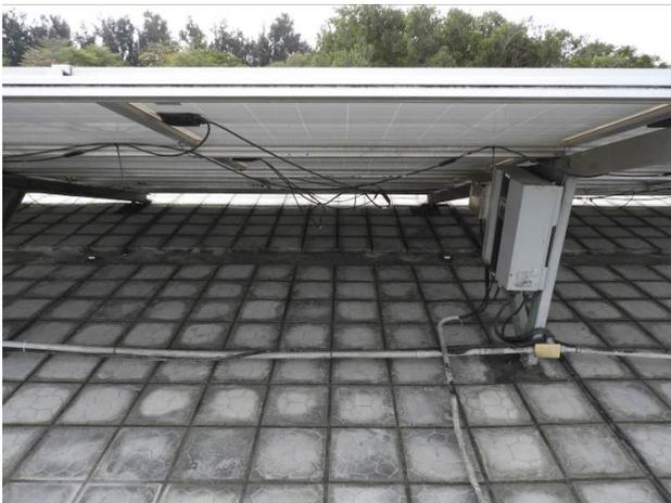
文字說明：將原本固定在地面的太陽能電板的管線上移約15公分，再進行鋪設防水毯及隔熱磚的工程。
