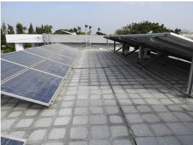
文字說明：太陽能電板拆遷需大筆額外經費，克服經費有限及不拆遷的情況下，改採鋪設防水毯及隔熱磚方式，達到防水隔熱的效果。
