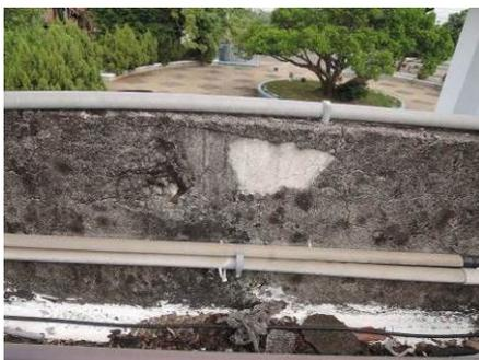
說明：多處女兒牆破損嚴重，無防水效果
