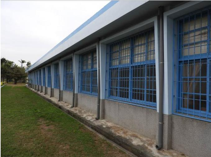
文字說明：頂樓鑽設多處排水孔及明管，將頂樓的洩水直接導引到地面的排水溝。
