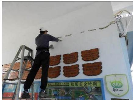
說明：裂縫以 EPOXY 注射
