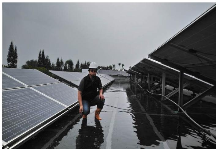
文字說明：鋪設完防水毯後進行72小時的試水，均無漏水之情形。
